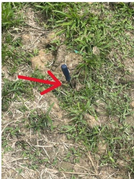
Chave de fenda topou na tubulação
