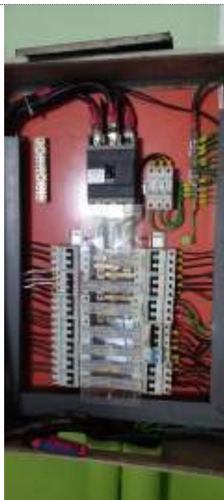
Imagens 07, 08 e 09 – Retirada QDF - AC 02 – Quadro de Distribuição e Força Ar Condicionado. (Local Próximo ao DAP).
