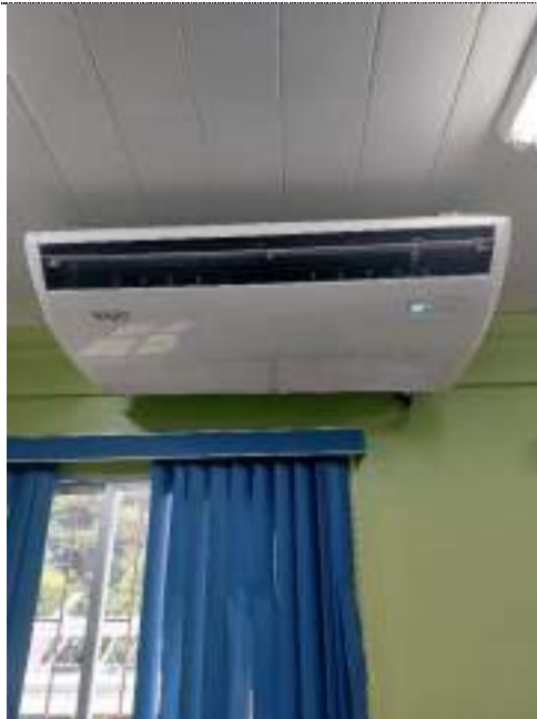
Imagens 04 e 05 – CRA - Manutenção Preventiva, Limpeza e Manutenção Corretiva, complemento do gás R410.
