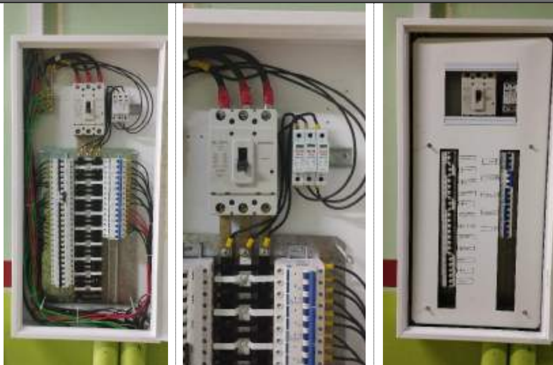
Imagens 24, 25 e 26 – Instalação Novo QDF 06 - AC 01 – Quadro de Distribuição e Força Ar Condicionado. (Local Próximo a CGTI).
