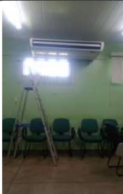
Imagem 03 – Vídeo Conferência - Manutenção Preventiva - Limpeza e Manutenção Corretiva - Reparos barulhos na Grade Difusor de Ar.
