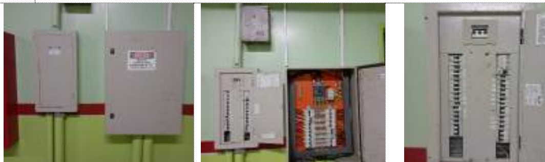
Imagens 14, 15 e 16 – Retirada QDLF 03 – Quadro de Distribuição Luz e Força – Iluminação e Tomadas. (Local Próximo ao DAP).
