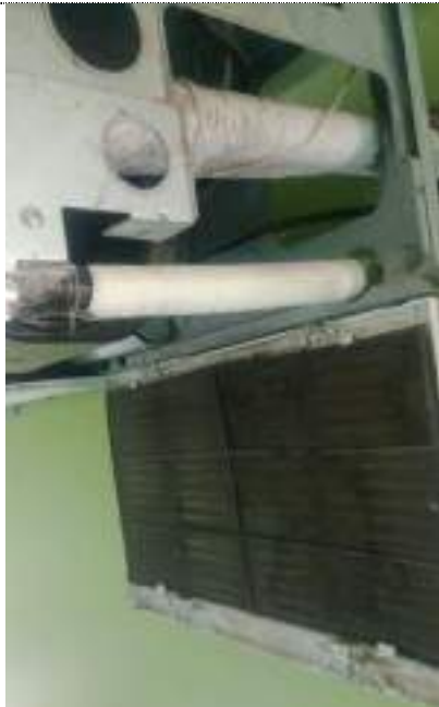
Imagens 04 e 05 – CRA - Manutenção Preventiva, Limpeza e Manutenção Corretiva, complemento do gás R410.
