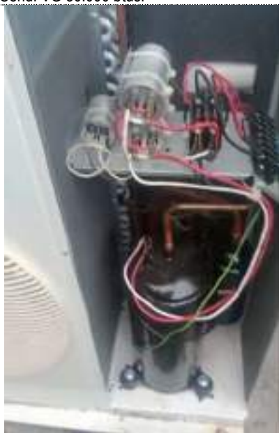
Imagem 07 – Laboratório de Recursos Pesqueiros - Manutenção Corretiva; Substituição de Capacitores e Conserto de Vazamento de Gás. Imagem 08 – Sala de Estudos Professores – Manutenção Preventiva, Limpeza e Manutenção Corretiva, Reparos barulhos na Grade Difusor de Ar.
