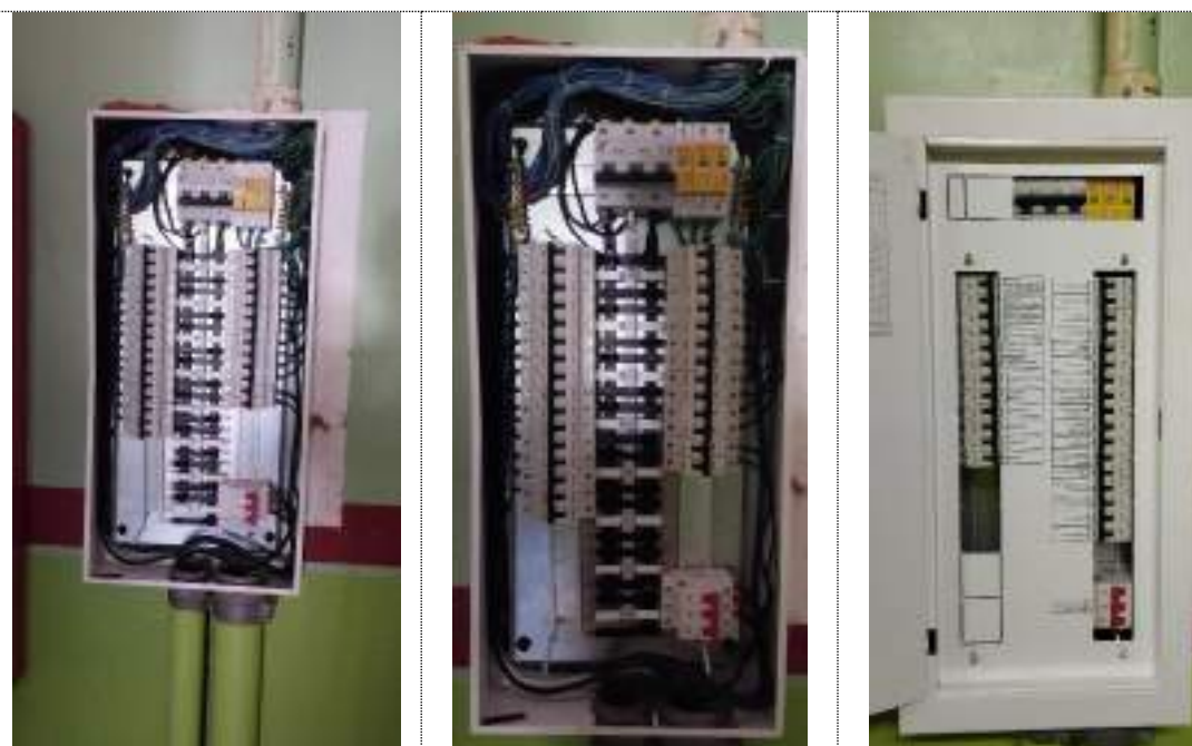
Imagens 17, 18 e 19 – Instalação Novo QDLF 03 – Quadro de Distribuição Luz e Força – Iluminação e Tomadas. (Local Próximo ao DAP).
