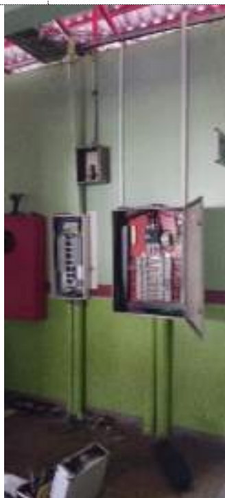
Imagens 07, 08 e 09 – Retirada QDF - AC 02 – Quadro de Distribuição e Força Ar Condicionado. (Local Próximo ao DAP).
