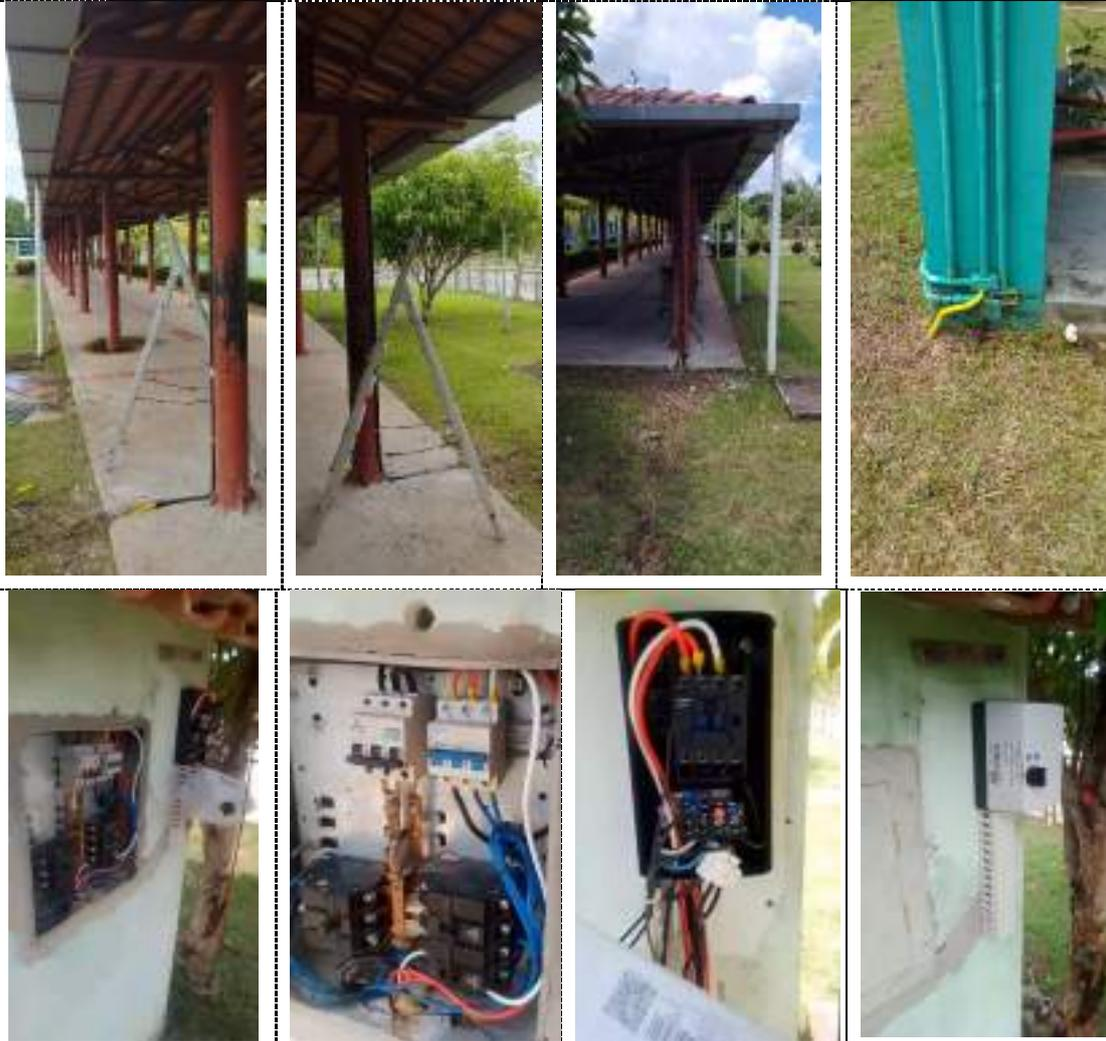
Imagens 32, 33, 34, 35, 36, 37, 38 e 39 - Instalação de Boia Elétrica e Contatora Poço Artesiano proximo a Piscina
