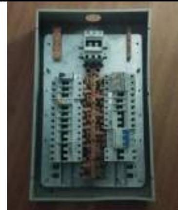
Imagens 01 e 02 - Quadro Auditório – retirada do QDLF – Quadro de Distribuição de Luz e Força existente.
