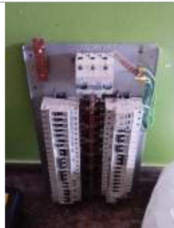
Imagens 28, 29 e 30 – Retirada QDLF 07 - Quadro de Distribuição de Luz e Força - (Local Próximo a CGTI).
