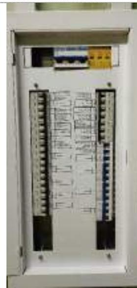
Imagens 24, 25 e 26 – Instalação QDLF 07 - Quadro de Distribuição de Luz e Força - (Local Próximo a CGTI).
