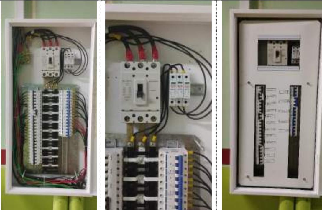
Imagens 24, 25 e 26 – Instalação Novo QDF 06 - AC 01 – Quadro de Distribuição e Força Ar Condicionado. (Local Próximo a CGTI).
