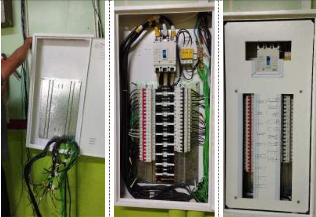
Imagens 10, 11 e 12 – Instalação Novo QDF - AC 02 – Quadro de Distribuição e Força Ar Condicionado. (Local Próximo ao DAP).
