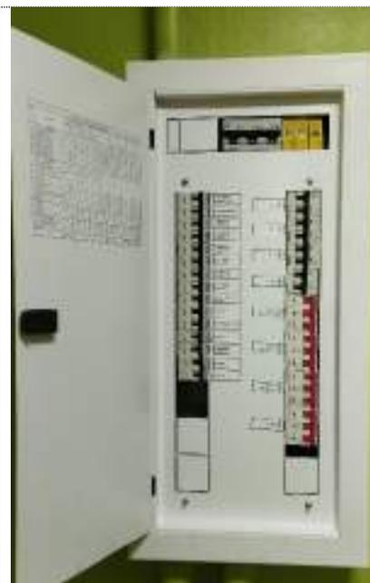
Imagens 03, 04 e 05 - Quadro Auditório – Instalação novo QDLF – Quadro de Distribuição de Luz e Força.
