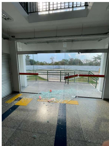
Fotografia 6 – Vista da porta da lateral direita do prédio do IFAM Campus Eirunepé (ou fachada nordeste da edificação) que quebrou sem que tenha sido efetuado uma má utilização da porta.
