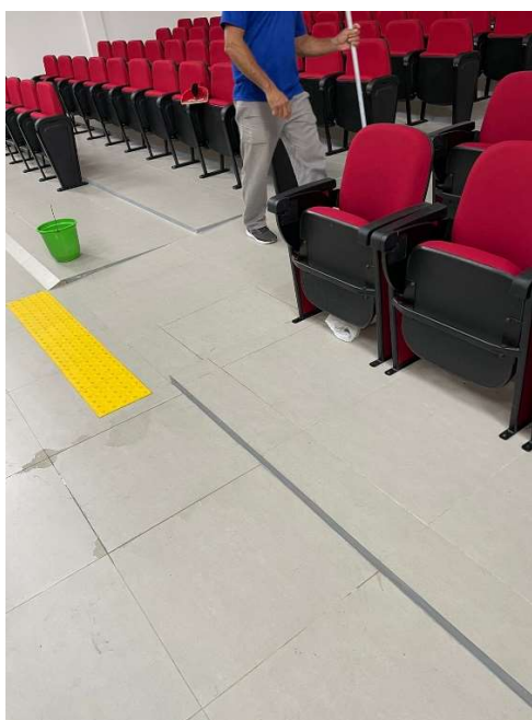
Fotografia 2 – Vista do piso do auditório molhado após chuva na região.
