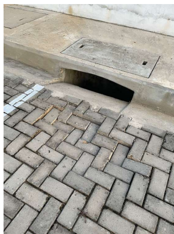
Fotografia 7 – Vista de trecho do piso intertravado em paver do IFAM Campus Eirunepé, é constatada a presença de grande irregularidade no piso e a falta de justas em areia (ou nata de cimento) para a proteção da base, o que causa irregularidades no piso.
