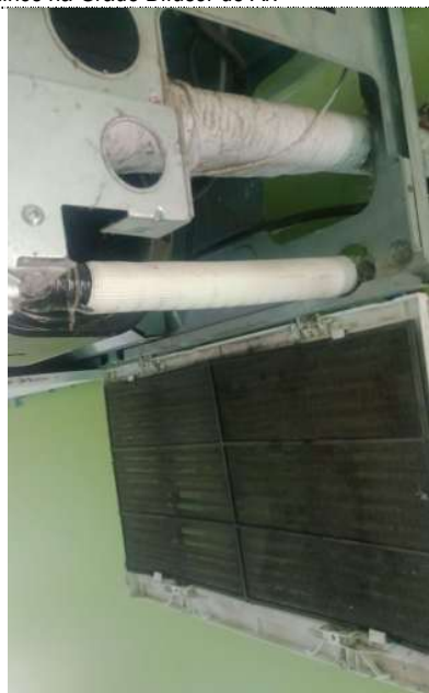
Imagens 04 e 05 – CRA - Manutenção Preventiva, Limpeza e Manutenção Corretiva, complemento do gás R410.
