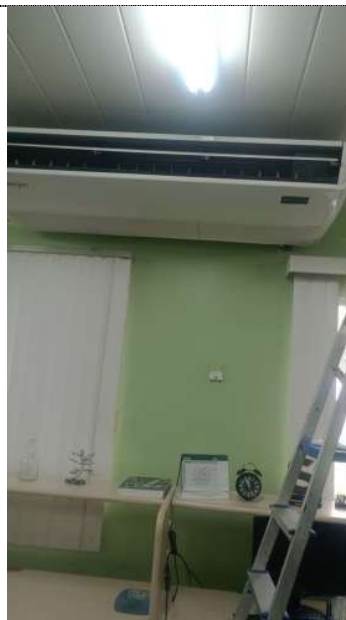
Imagem 07 – Laboratório de Recursos Pesqueiros - Manutenção Corretiva; Substituição de Capacitores e Conserto de Vazamento de Gás.
