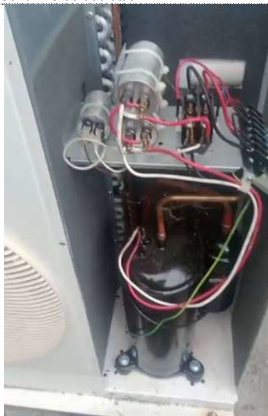
Imagem 07 – Laboratório de Recursos Pesqueiros - Manutenção Corretiva; Substituição de Capacitores e Conserto de Vazamento de Gás.
